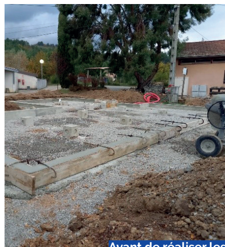
Avant de réaliser les fondations...
