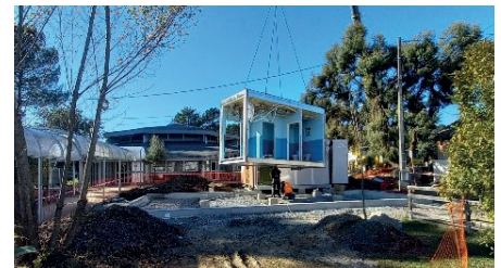
Dès l'arrivée des premiers blocs, l'installation commence
